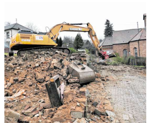
Mit Abriss der bestehenden Gebäude wurde der Weg für den neuen Kirchenvorplatz in Rauenberg freigemacht. BILD: GREIN
